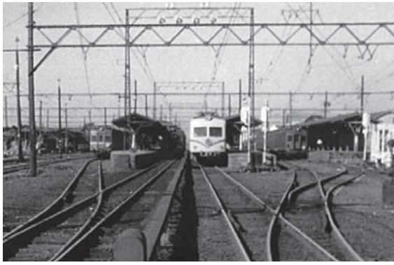
北1番踏切から プラットホームを望む
