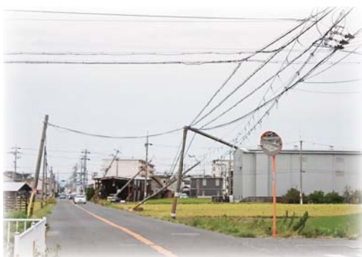
▲▶多くの樹木や電柱が倒れ、停電や断水が発生しました。
