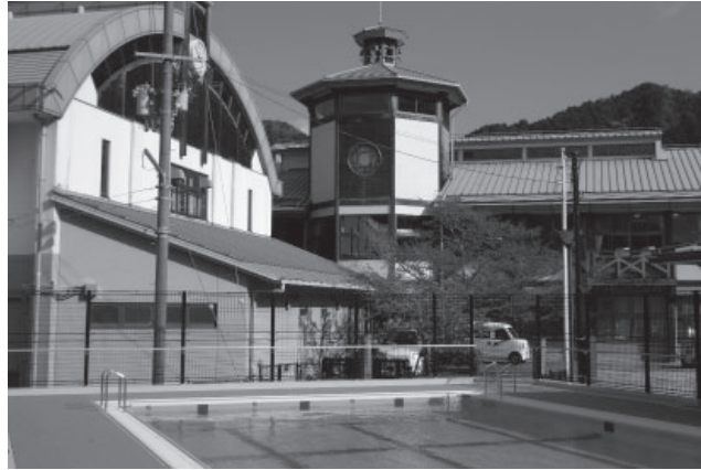
▲大木小学校校舎とプール
