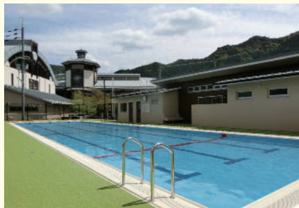
◀大木小学校プール
