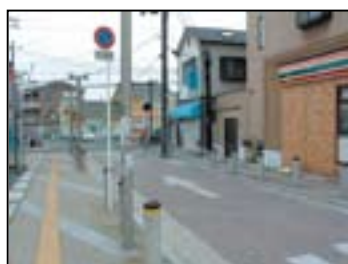
①歩道（区間Ⅰ-両側歩道） ・海側に有効幅員 2.5m、山側に同じく 2.0mの歩道が設置されている。
