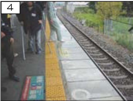
4 ・大阪方面行きホームの端部に滑り止めが設置されていない。
