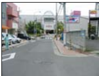
④歩道（区間Ⅲ-片側歩道） ・山側に有効幅員 1.9mの歩道が設置されている。 ・歩道内に電柱が2本あり通行の障害となっている。
