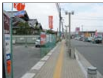
②歩道（区間Ⅱ-片側歩道） ・海側に有効幅員 2.0mの歩道が設置されている。
