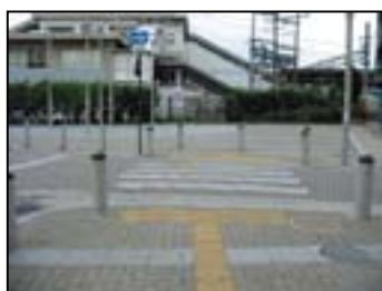
② 横断歩道 (1) ・段差は 2 cm 以下である。 ・点字ブロックがある。
