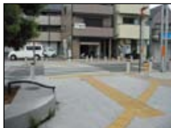
④ 横断歩道 (2) ・視覚障害者誘導用ブロックが連続しており、駅前広場各施設を結んでいる。
