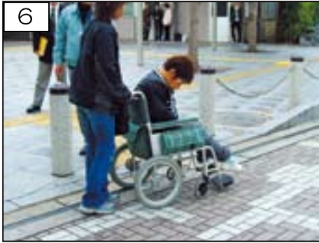
6 ・車いす使用者用停車スペースの車止めが乗降時の支障となる。 ・雨よけの屋根がない。
