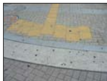
③ 横断歩道に接続する歩道部分 (左写真の詳細) ・浸透性効果のある舗装がなされている。 ・段差は 2 cm 以下である。 ・視覚障害者誘導用ブロックがある。
