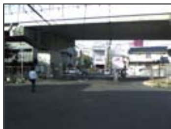
③府道土丸栄線(高架下) ・道路幅員が広く、歩道が連続していない。 ・横断歩道が設置されていない。
