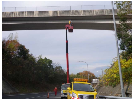
点検の状況（橋梁点検車）
