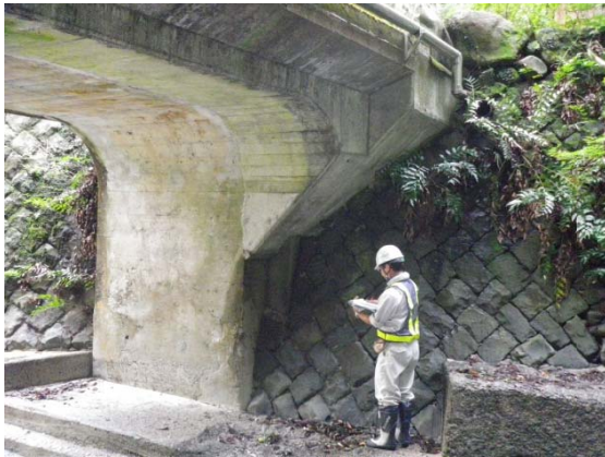
点検の状況（目視）
