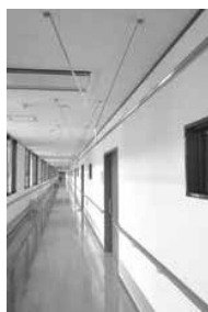
●廊下の盲導線(天井)
