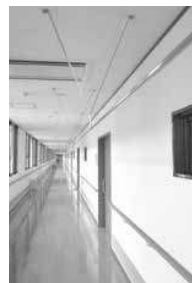
●廊下の盲導線(天井)
