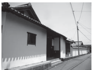
▲奥家外観(熊野街道側より)
