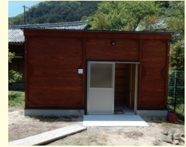
▶ 土丸地区トイレ
