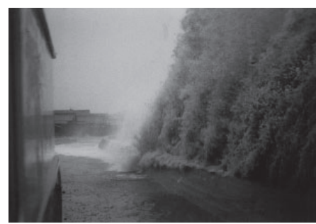
▲春日町海岸防潮堤にたたきつけた高さ12mの波浪
