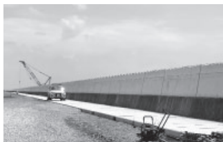
▲護岸高上げ工事
