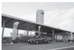
▲水素エネルギーの活用
