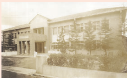
▲昭和29年ごろの旧泉佐野市役所の写真。正面入口は第二小学校へ向かう道に面して建っていた。入口の上には「泉佐野市役所」と記されていた。
