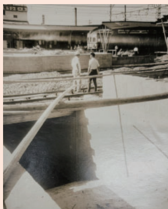
◀ 泉佐野駅の地下駅の工事中。地下駅舎は昭和40年10月から営業を開始しました。
