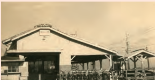
▲昭和27年頃の羽倉崎駅の写真。羽倉崎駅は明野陸軍飛行学校佐野分教所の陸軍佐野飛行場の建設に関わる人々や建設機材を輸送するため、昭和17年に開設されました。
