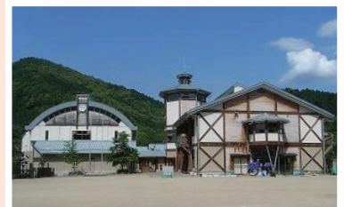
▲現在の大木小学校の校舎。旧校舎の老朽化により、平成13年に新校舎が竣工しました。新校舎は、木のぬくもりや温かさがわかるような木造校舎となっています。
