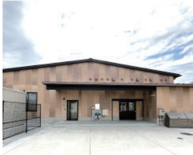
▲小学校給食自校方式施設整備 (第二小学校)
