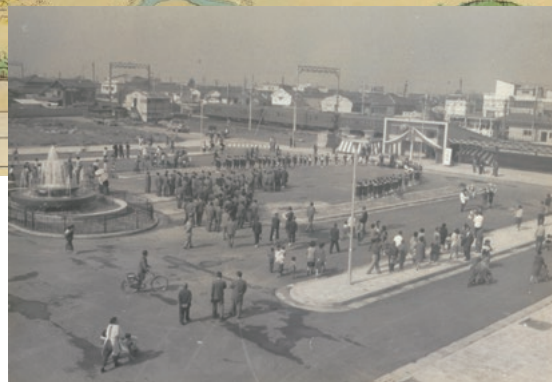
泉佐野駅地下道完成 (昭和40年)
