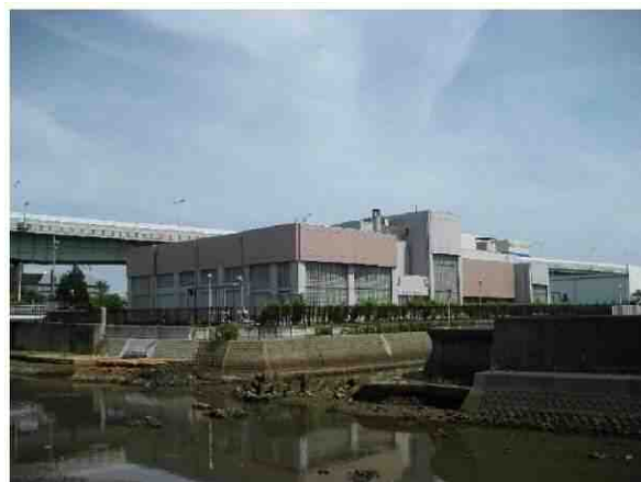
北ポンプ場（住吉町）
