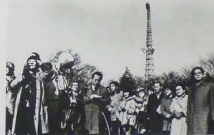
和歌山県に核攻撃の被害報告をつたえる通信網の一端をみる。大和川のアメリカ軍通信基地（埼玉県草加市）。
