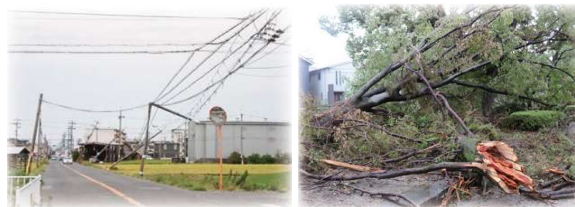
2018年の台風21号における泉佐野市内の被害 （出典）広報いずみさの 平成30年10月号
