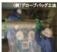
（例）グローブバッグ工法 隔離＋集じん・排気装置を使用する方法に準じる方法
