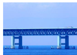
■ 海上部（空港連絡橋）
