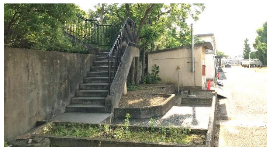
▲庁舎本館 南側 急勾配な階段
