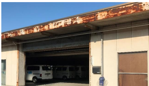
▲庁舎別館 外部
