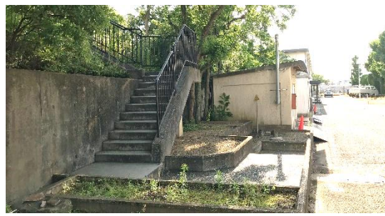
▲庁舎本館 南側 急勾配な階段
