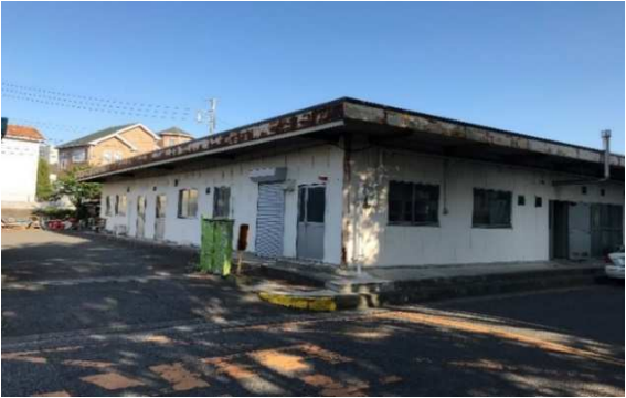
老朽化が進行している現在の庁舎別館（公用車駐車場棟）
