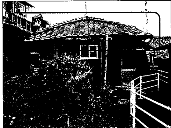
屋根に不陸がある例
