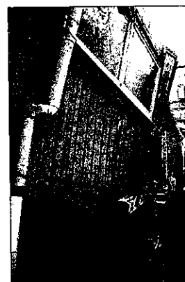
柱の変形が著しく崩壊の危険がある例
