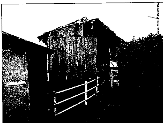
一部の柱が傾斜している例
