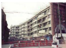
RC造・ラーメン構造の細長い住棟(5階建て)
