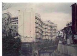
RC造・ラーメン構造の細長い住棟(5階建て)
