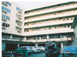
SRC造・ラーメン構造のL字型住棟
