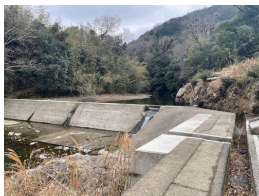
土丸大井井堰
