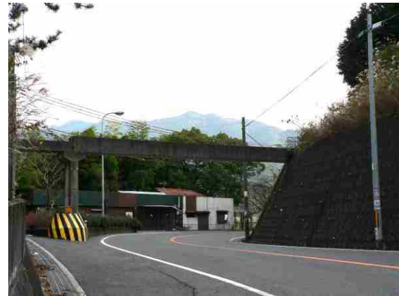
府道峠と大井水路
