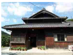
腰上げ民家 一階の外壁の内側に つしの外壁がのっている
