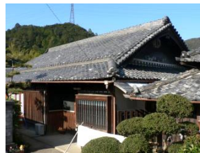
(写真3) 瓦葺き平屋（しころ）
