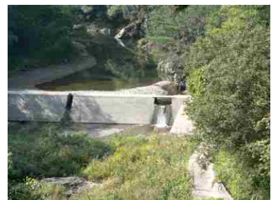
土丸大井井堰
