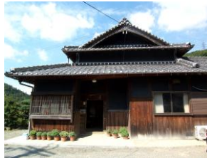
(写真2) 瓦葺きつし二階（腰上げ）
