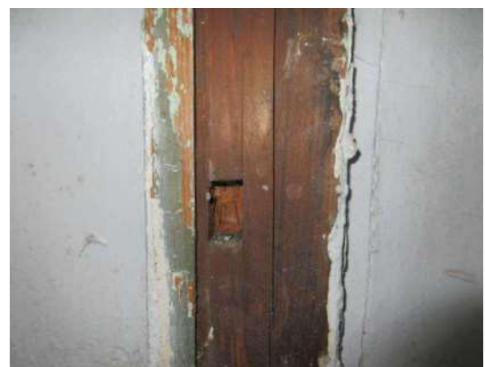
写真 3-1-228 板溝と胴縁痕跡
