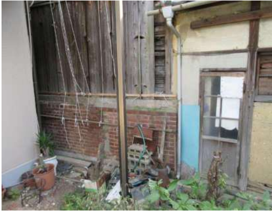
写真 3-1-30 浴室レンガ基礎
