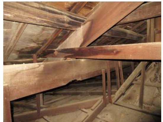
写真 3-1-213 敷梁と登梁の接続部 下弦材はボルト留め
