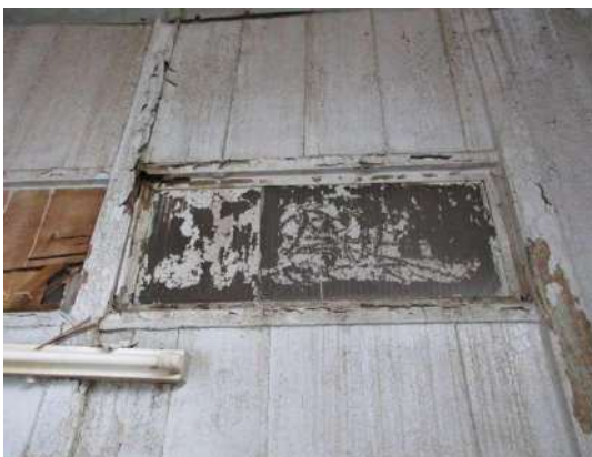
写真 3-1-192 脱衣室・浴室境の塞がれていた欄間
