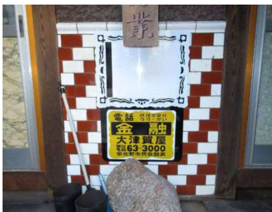
写真 3-1-241 下足室のタイル
