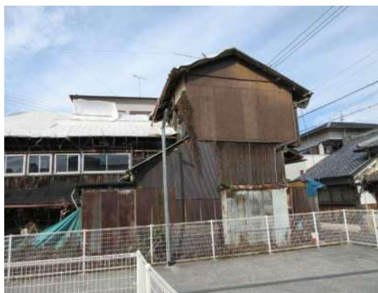
写真 3-1-78 外壁の劣化
