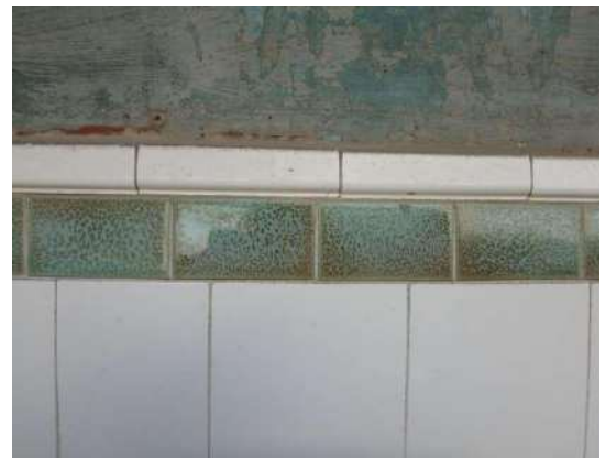
写真 3-1-236 塀のタイル（西側）
