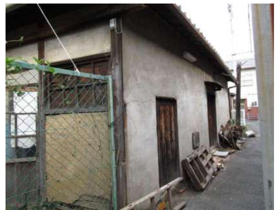
写真 3-1-29 モルタル塗籠の外壁
