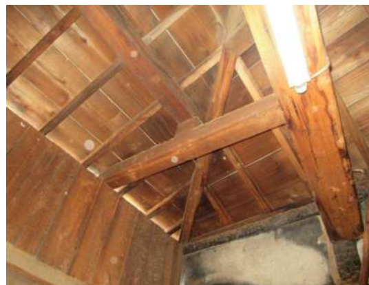
写真 3-1-44 細い隅木を入れ振隅で納める
