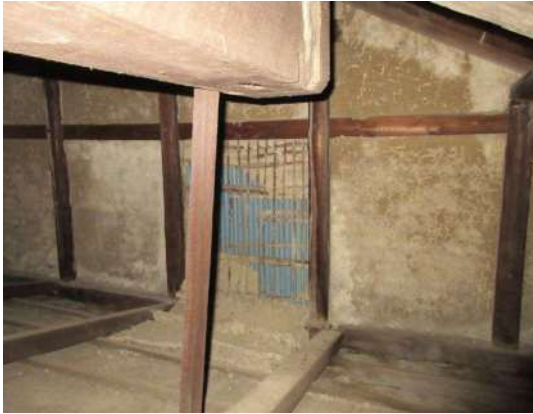
写真 3-1-142 妻壁の崩落
