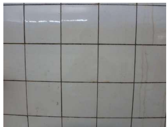
写真 3-1-242 浴室のタイル 塀のタイルと酷似している
