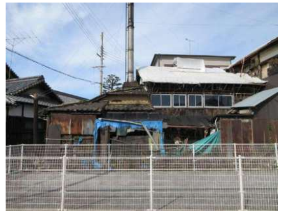
写真 3-1-20 釜場棟外観（煙突以右は浴室棟）
