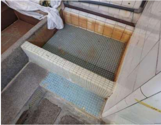
写真 3-1-18 副浴槽のモザイクタイル
