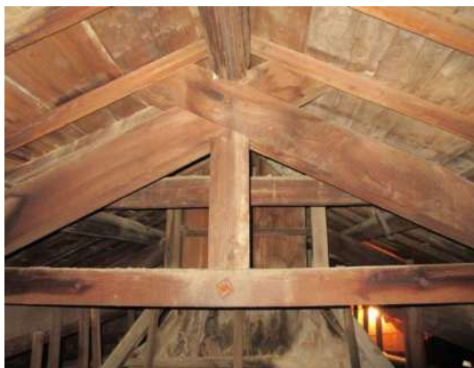
写真 3-1-39 トラス風登梁（頂部）
