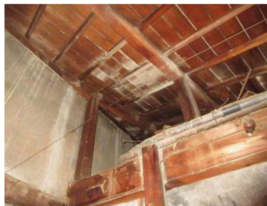
写真 3-1-42 水槽の縁ギリギリに束を置く
