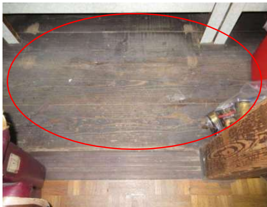
写真 3-1-200 前栽を室内化した際の床板
