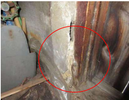
写真 3-1-150 柱脚の腐朽
