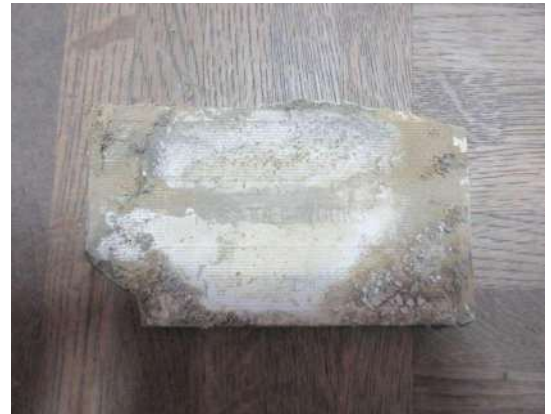
写真 3-1-240 ボーダータイル裏面
