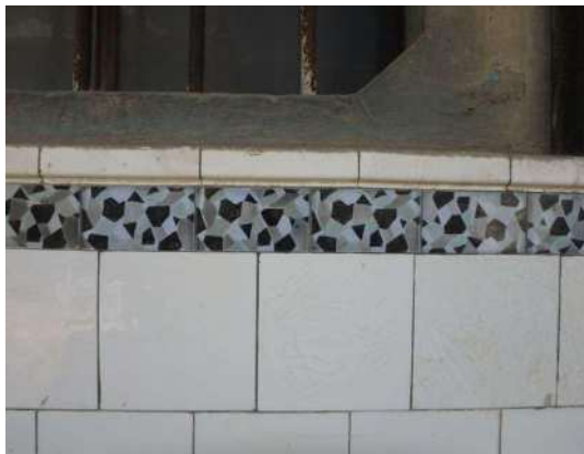
写真 3-1-235 塀のタイル（東側）
