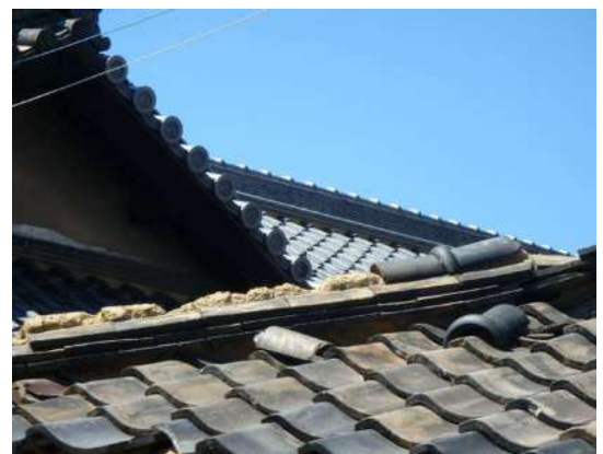
写真 3-1-160 棟瓦の落下
