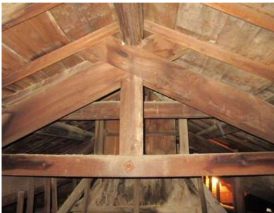
写真 3-1-212 トラス風登梁の頂部
