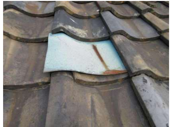
写真 3-1-152 割れた瓦を補修する金属板
