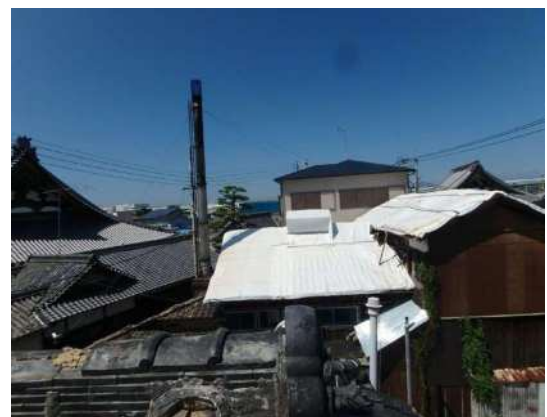
写真 3-1-45 防水シートで覆われる屋根
