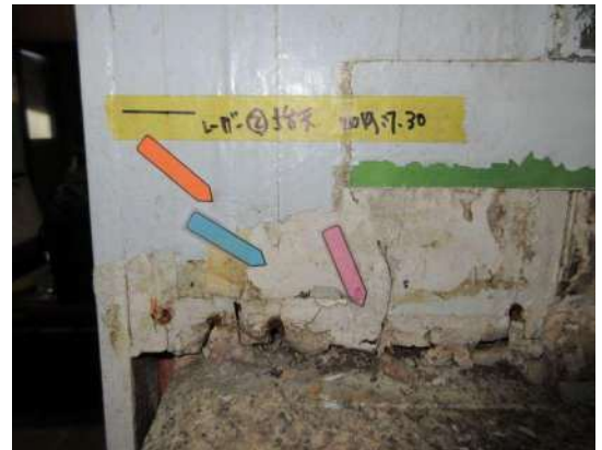
写真 3-1-119 少なくとも3層の塗装が見える
