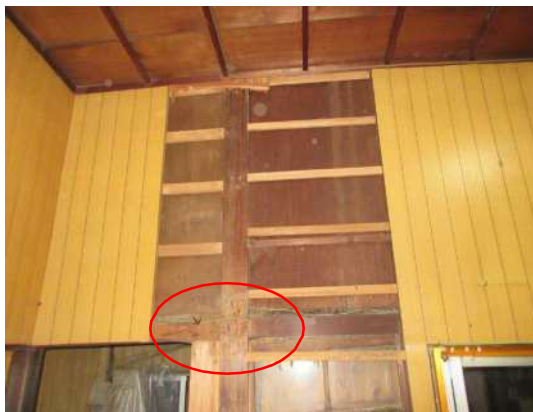
写真 3-1-179 新建材（化粧ベニヤ）一部解体
