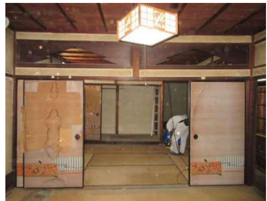
写真 3-1-12 次の間より座敷側を見る
