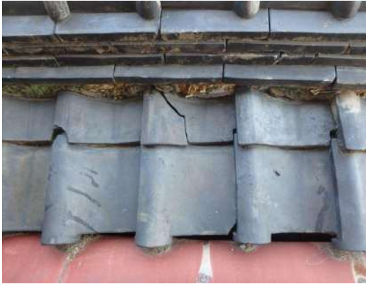
写真 3-1-100 平瓦の割れ
