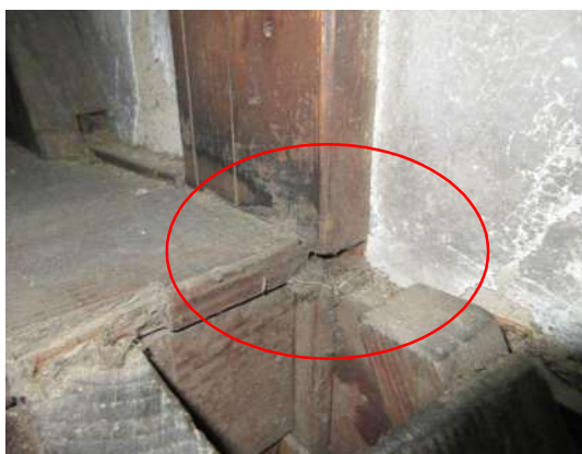
写真 3-1-181 X1-Y7 柱の首切り痕跡 階段踊り場は後設か
