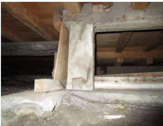
写真 3-1-198 土間を囲む礎石
