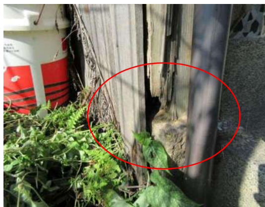
写真 3-1-79 柱脚の腐朽
