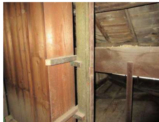
写真 3-1-221 鐏付の束 旧越屋根の棟木と推定される
