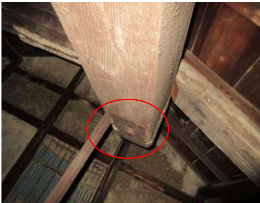
写真 3-1-210 敷梁端部下端の枅穴及び柱の圧痕
