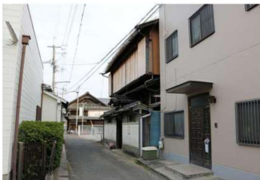
写真 3-1-2 前面道路より大將軍湯を見る（右手）
