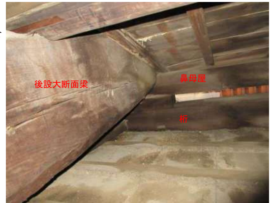
写真 3-1-222 後設された大断面梁
