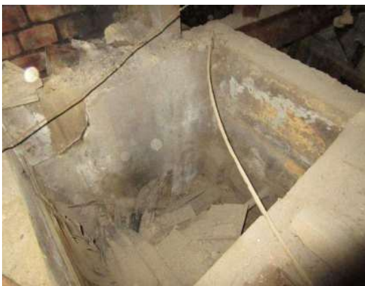
写真 3-1-28 釜置場上部の水槽
