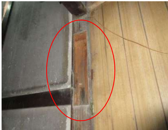
写真 3-1-183 X1-Y8 柱 貫及び埋木痕跡
