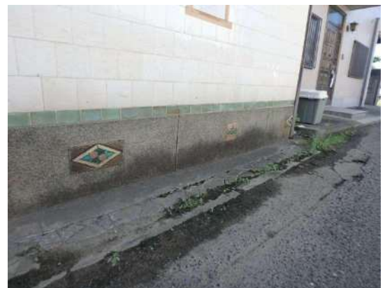
写真 3-1-57 前面道路側塀のタイル（下部）
