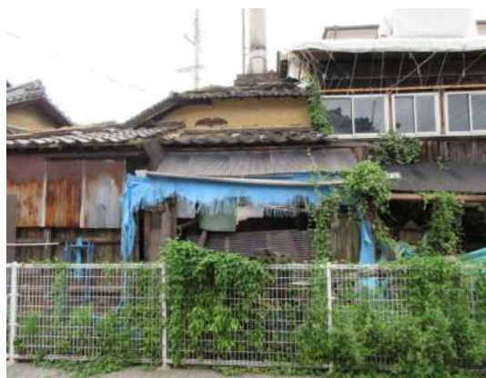
写真 3-1-77 外壁の劣化
