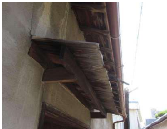
写真 3-1-167 板底の劣化
