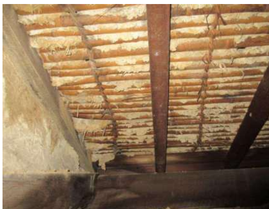
写真 3-1-46 表棟の屋根下地（竹小舞）
