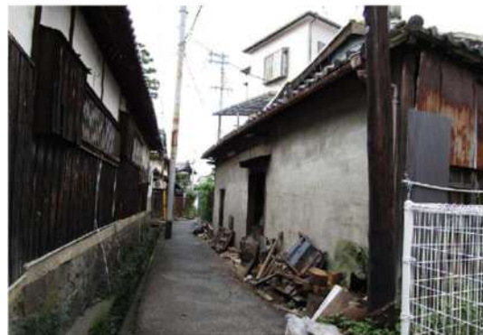
写真 3-1-3 背面道路（南側道路）
