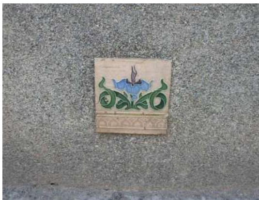
写真 3-1-56 基礎部のマジョリカタイル
