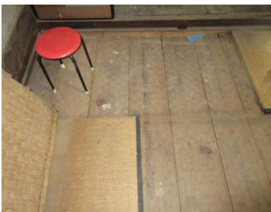
写真 3-1-204 2階荒床（柾）のトレードマーク
