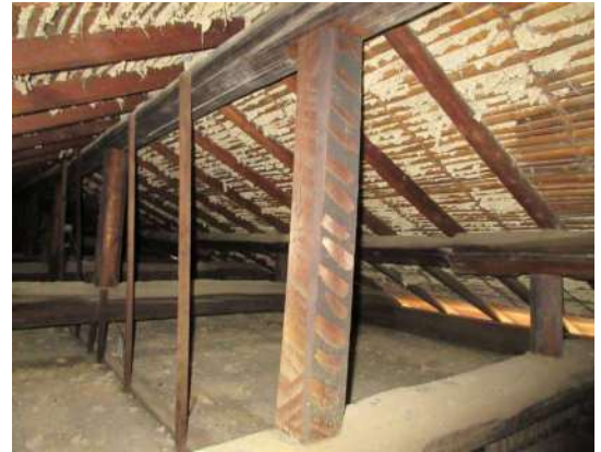
写真 3-1-203 意図的に斬で斫られている
