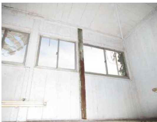
写真 3-1-227 X4-Y15 柱に残る板壁痕跡
