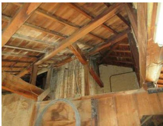
写真 3-1-41 釜場棟小屋組
