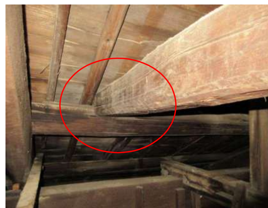
写真 3-1-219 越屋根受け梁と母屋の接続部
