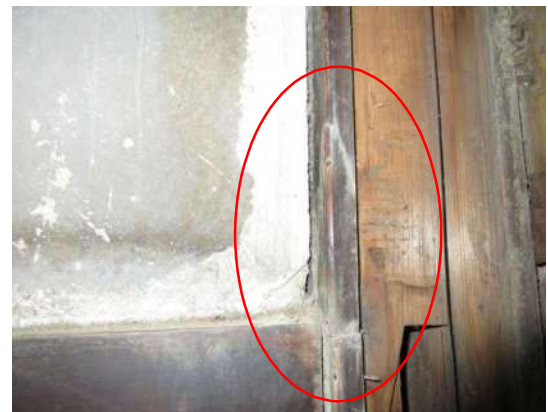
写真 3-1-180 X1-Y8 柱（隅柱）の長押痕跡
