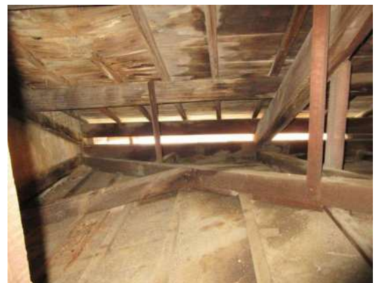
写真 3-1-40 トラス風登梁（端部）
