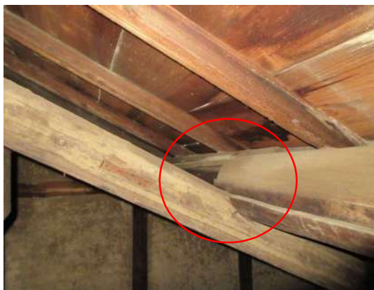
写真 3-1-208 母屋の継手（「Y15 通り」付近）
