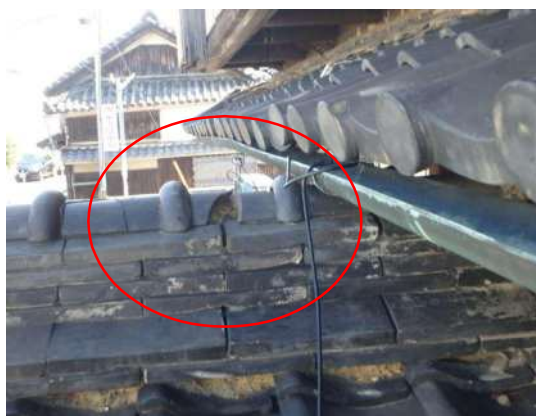
写真 3-1-65 棟瓦の割れ
