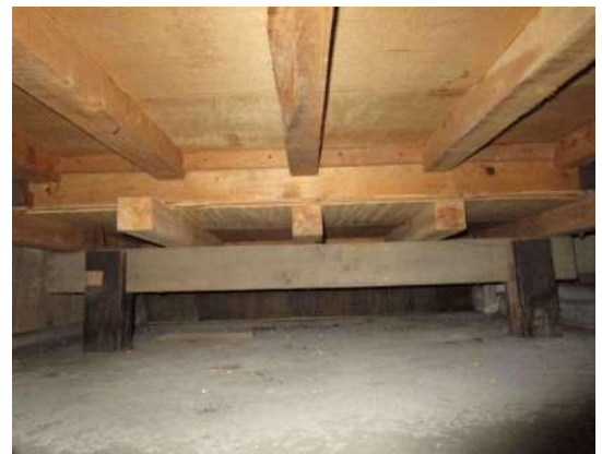
写真 3-1-197 礎石で囲まれたコンクリート土間
