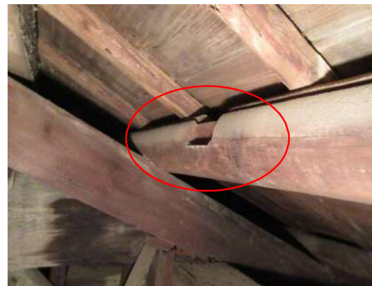
写真 3-1-217 当初の越屋根受け梁痕跡（西側） （Y13 通り付近）
