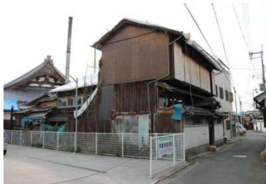
写真 3-1-4 前面道路より表棟・浴室棟・釜場棟が並ぶ
