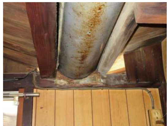
写真 3-1-61 樋端部の錆
