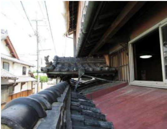
写真 3-1-102 軒樋の脱落
