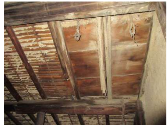
写真 3-1-108 竹小舞から野地板への改修箇所
