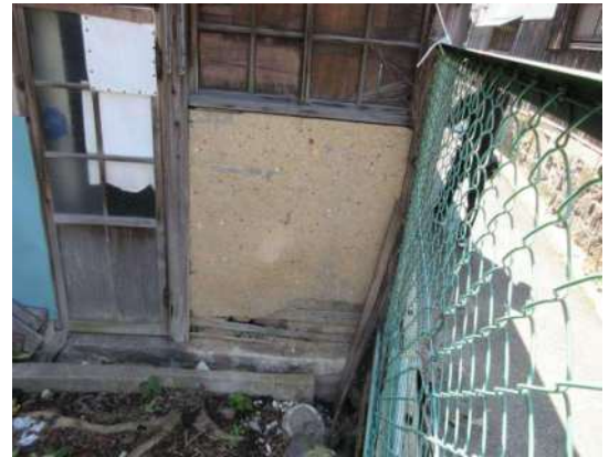
写真 3-1-166 土壁の崩落
