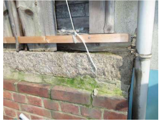
写真 3-1-31 レンガ基礎上の土台石
