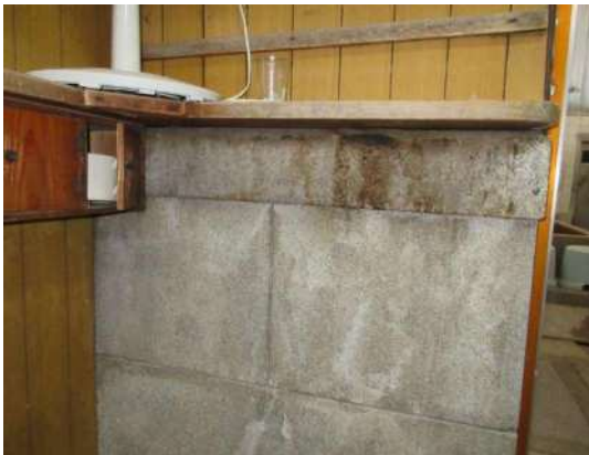
写真 3-1-69 洗い出し部の水染み
