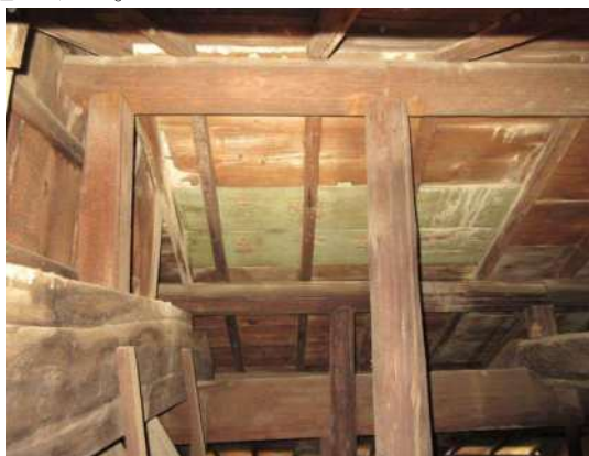
写真 3-1-220 塗装された野地板 旧越屋根の部材と推定される
