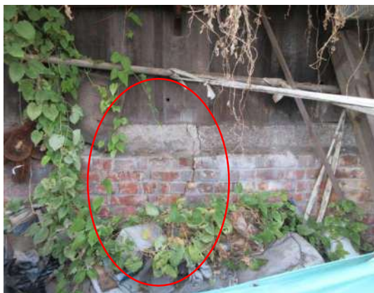
写真 3-1-225 レンガ基礎の継手（東側） 西側と同じく Y15 通り付近で継手が見られる
