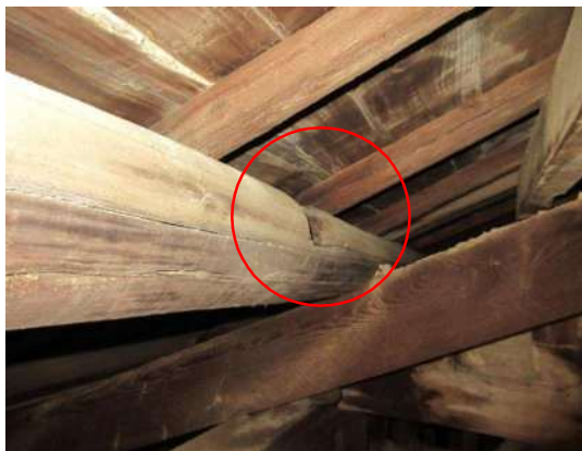
写真 3-1-216 当初の越屋根受け梁痕跡（東側） （Y13 通り付近）
