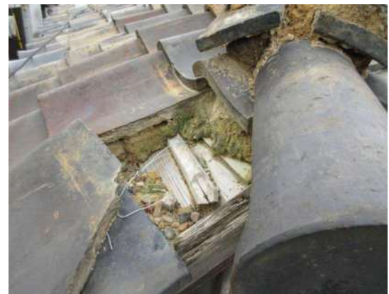
写真 3-1-154 平瓦の脱落
