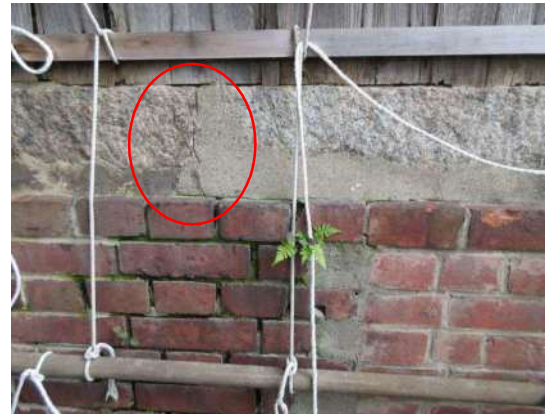
写真 3-1-224 土台石の継手 レンガ基礎よりやや北側に継手があり、モルタルにより接着されている
