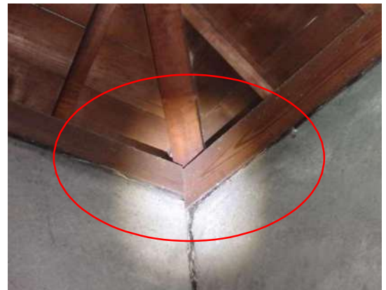
写真 3-1-149 桁内側に焦げを隠す板を張る
