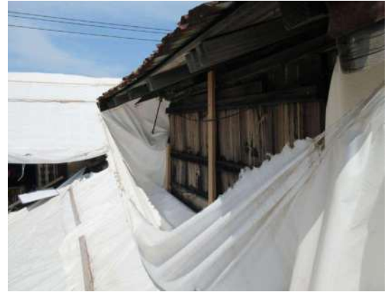
写真 3-1-19 浴室棟越屋根
