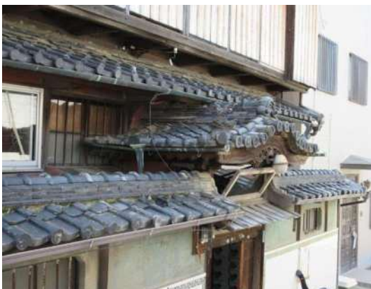
写真 3-1-50 軒先瓦の仕様差
