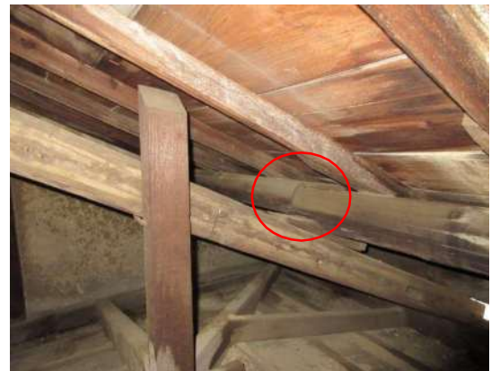
写真 3-1-207 母屋の継手（「Y15 通り」付近）
