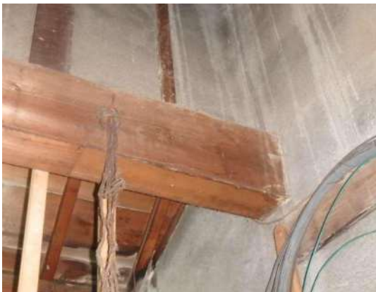
写真 3-1-148 焦げた梁に張られた化粧板
