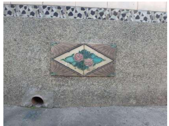
写真 3-1-55 基礎部のマジョリカタイル
