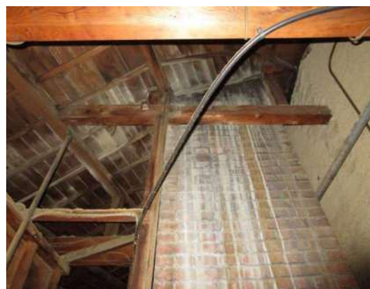
写真 3-1-25 煙突レンガ部
