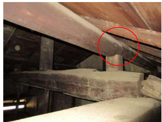
写真 3-1-209 母屋の継手（「Y15 通り」付近）
