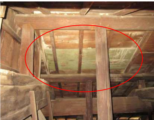
写真 3-1-138 取替（転用）られた野地板
