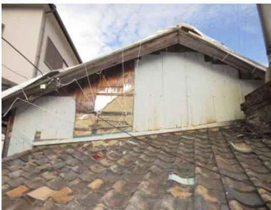
写真 3-1-21 釜場棟屋根と浴室棟接続部の納まり
