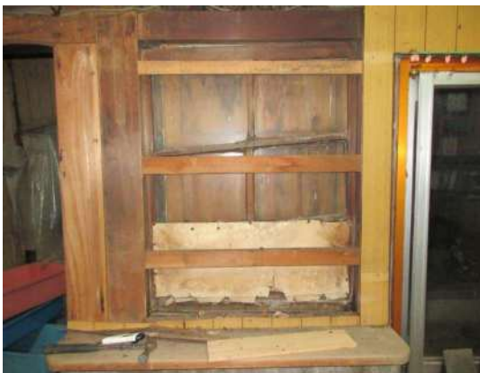
写真 3-1-187 脱衣室・浴室境の塞がれていた窓
