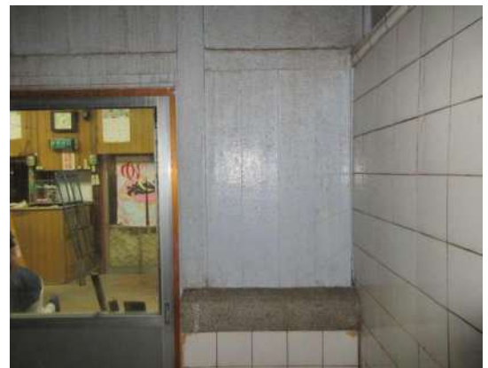
写真 3-1-189 浴室側から窓部を見る
