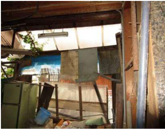
写真 3-1-26 簡易な屋根が掛けられた東側下屋
