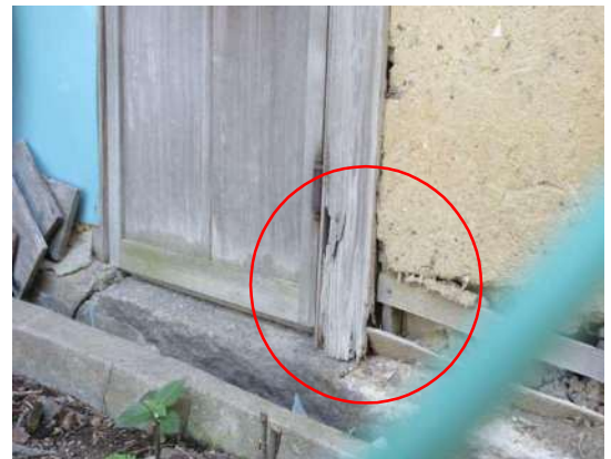
写真 3-1-151 柱脚の腐朽
