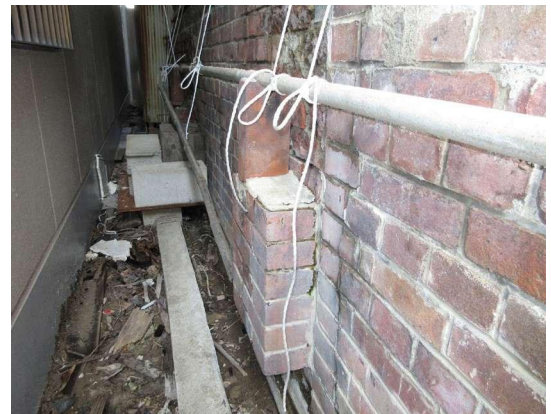
写真 4-1-12 敷地西側の排水路
