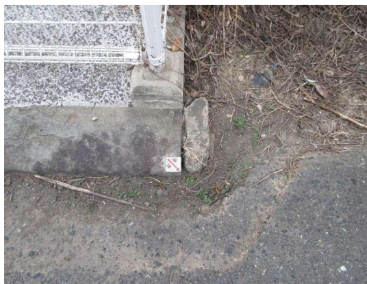
写真 4-1-5 北東隅境界標
