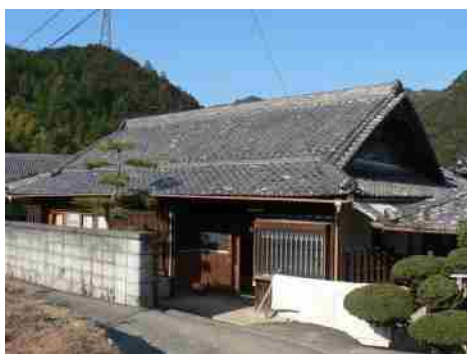
しころ屋根の民家
