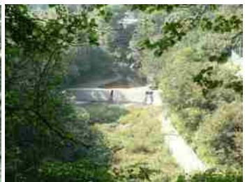
土丸大井井堰
