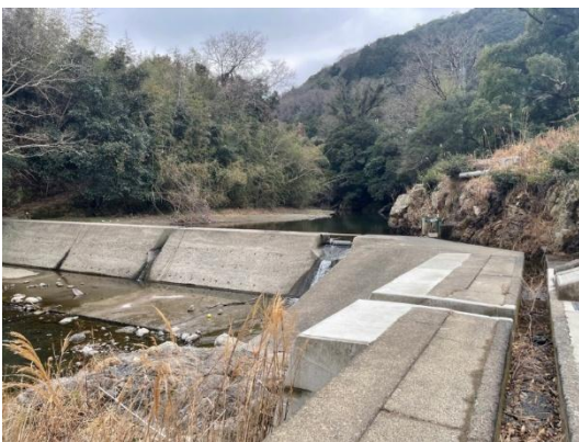
土丸大井井堰
