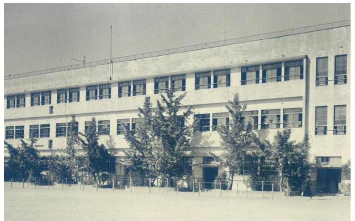
昭和 40 年 鉄筋 3 階建校舎
