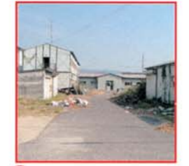
5 空き家です、立入禁止！
